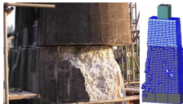
図-1 新潟県中越地震における打継目の水平ずれ 2) (左)と再現解析結果(右)
