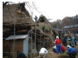
ボランティアによるササ葺き屋根の修復作業（京丹後市大宮町五十河）
