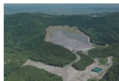
廃棄物最終処分場の全景
