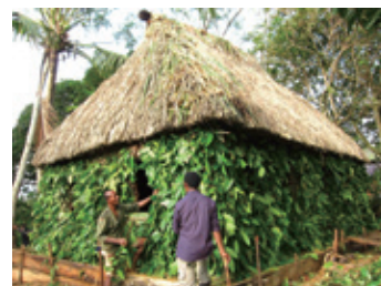
フィジー伝統木造建築・ブレの再建
