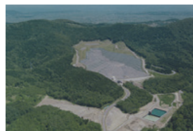
廃棄物最終処分場の全景
