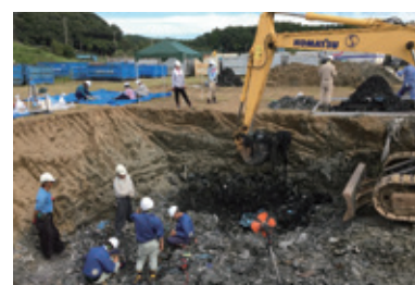
廃棄物処分場での現地調査の様子
